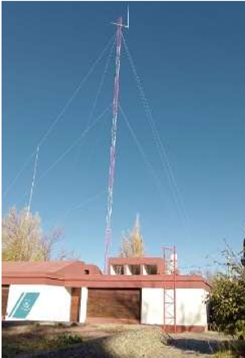
Torre de comunicaciones
