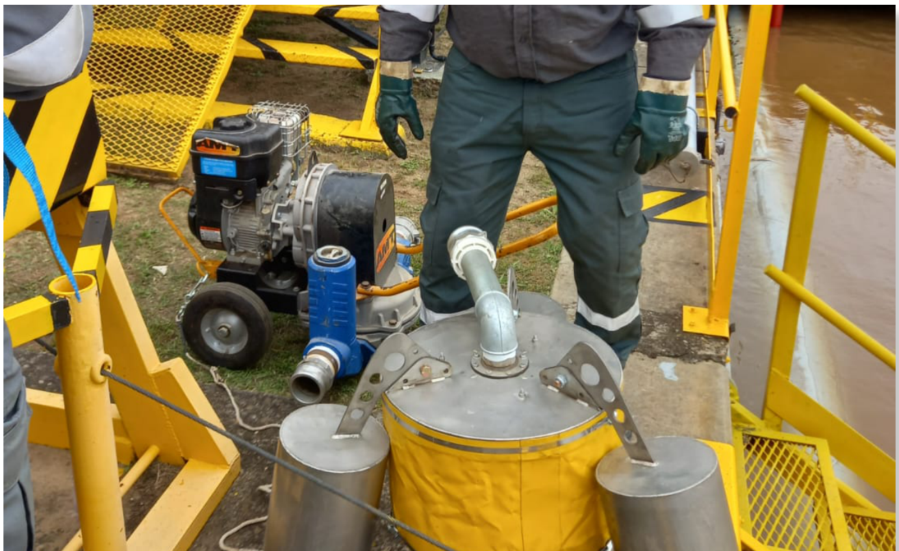
Imagen control de SKIMMER
