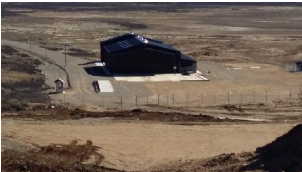
Vista de la planta de separación
