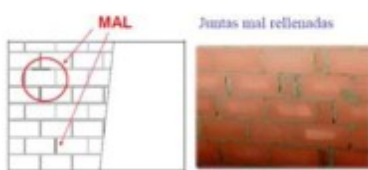
Figura 6.20. Especial cuidado con las discontinuidades en los morteros de pega. (Fuente: IETcc-CSIC, 2009)
