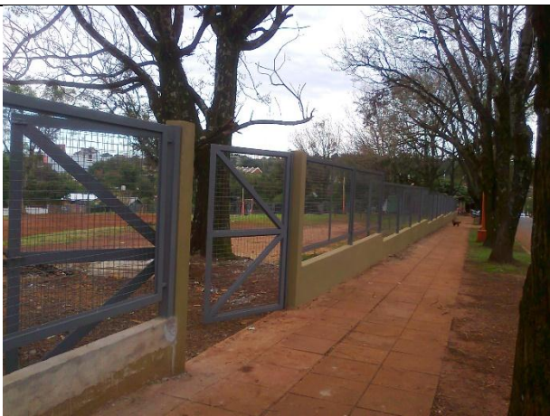
3- Acceso vehicular existente y esquina
