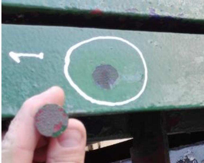
preparación de superficies para grado de corrosión E1.
