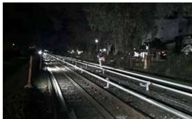
LP14/2017 Renovación de Tercer Riel
