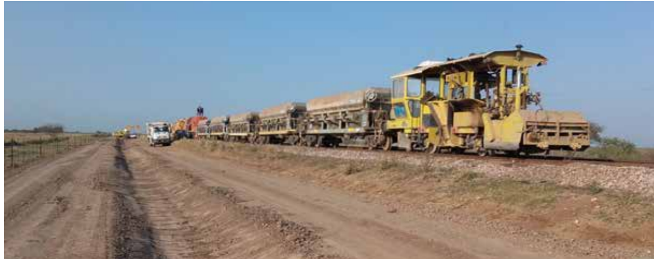
2Tareas de Renovación de Vías
