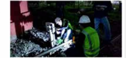
Trabajos en la Línea Mitre, ramal Suarez
