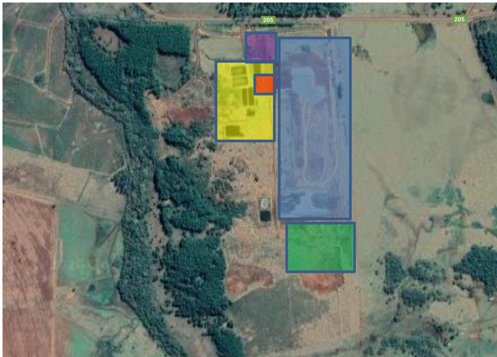
Relleno Sanitario Fachinal
