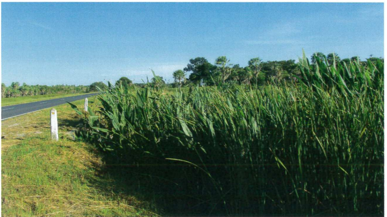
Sección S2. Vegetación en alcantarillas.
