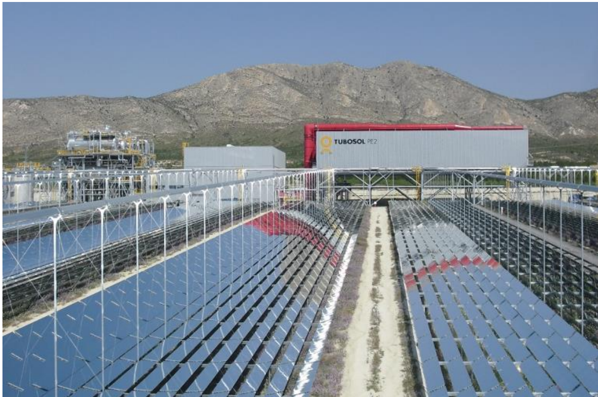
Figura 4. Planta Solar Puerto Errado 2. Murcia, España. Fuente: Revista Eólica y del Vehículo Eléctrico (REVE)
