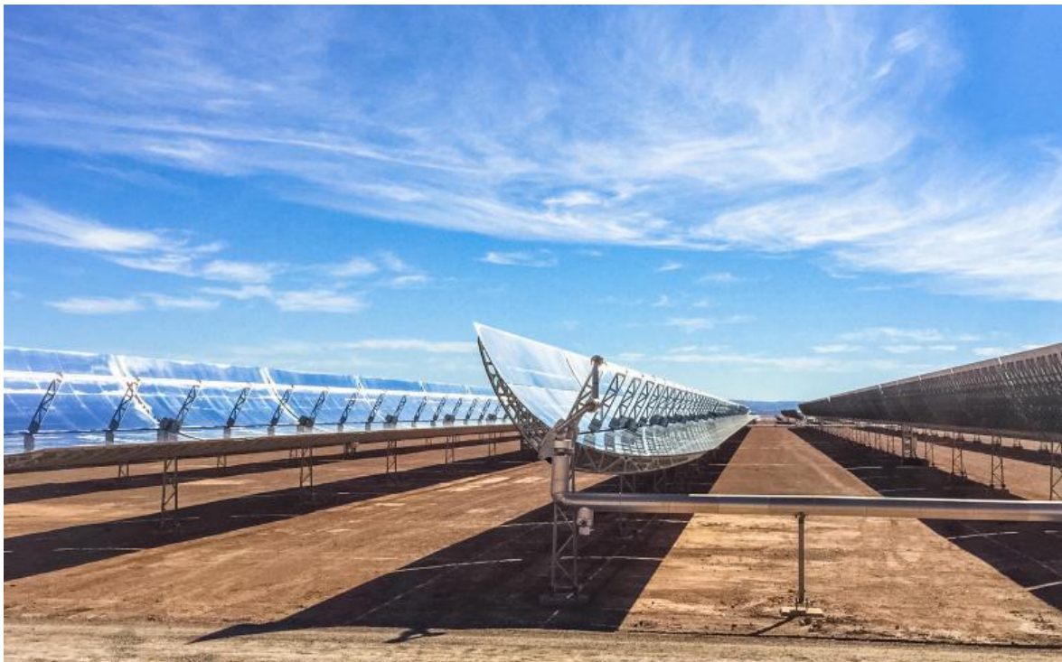
Figura 3. Planta Solar Noor Ouarzazate I. Uarzazate, Marruecos. Fuente: SENER
