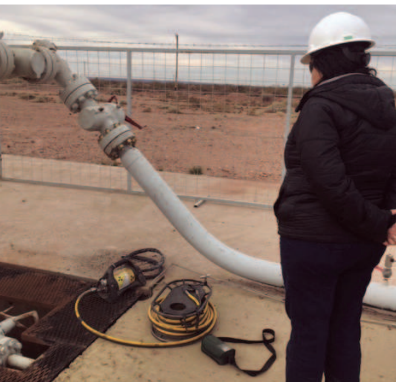
Inspección regulatoria a una instalación licenciada que realiza gammagrafía industrial sobre cañerías de gas (Provincia de Neuquén)
