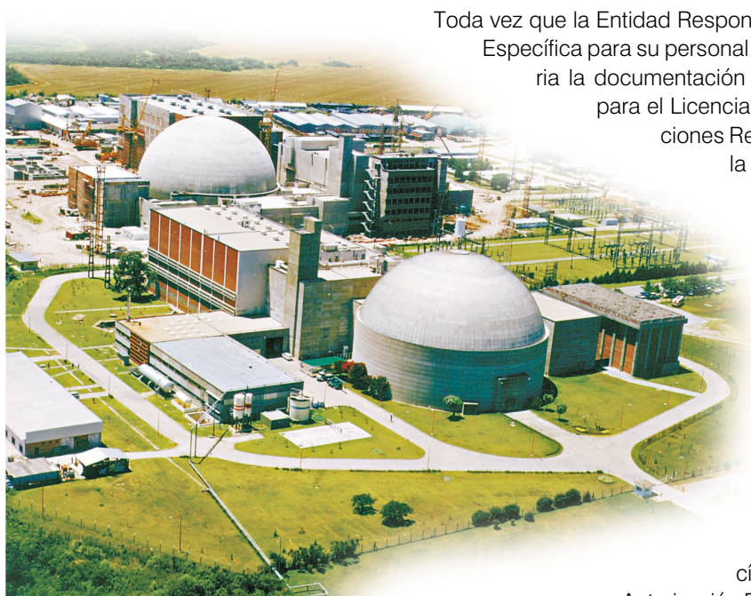
Vista panorámica de la Central Nuclear Atucha I
