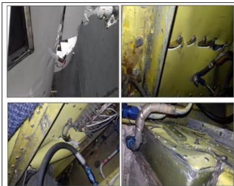
Fig. 2: Detalles de daños en sector del tren de nariz
