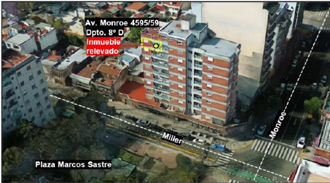
Vista aérea 3D de localización del inmueble.
