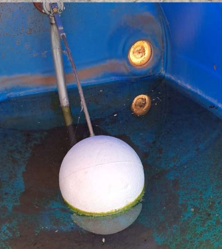
Vista de válvula con flotante instalada
