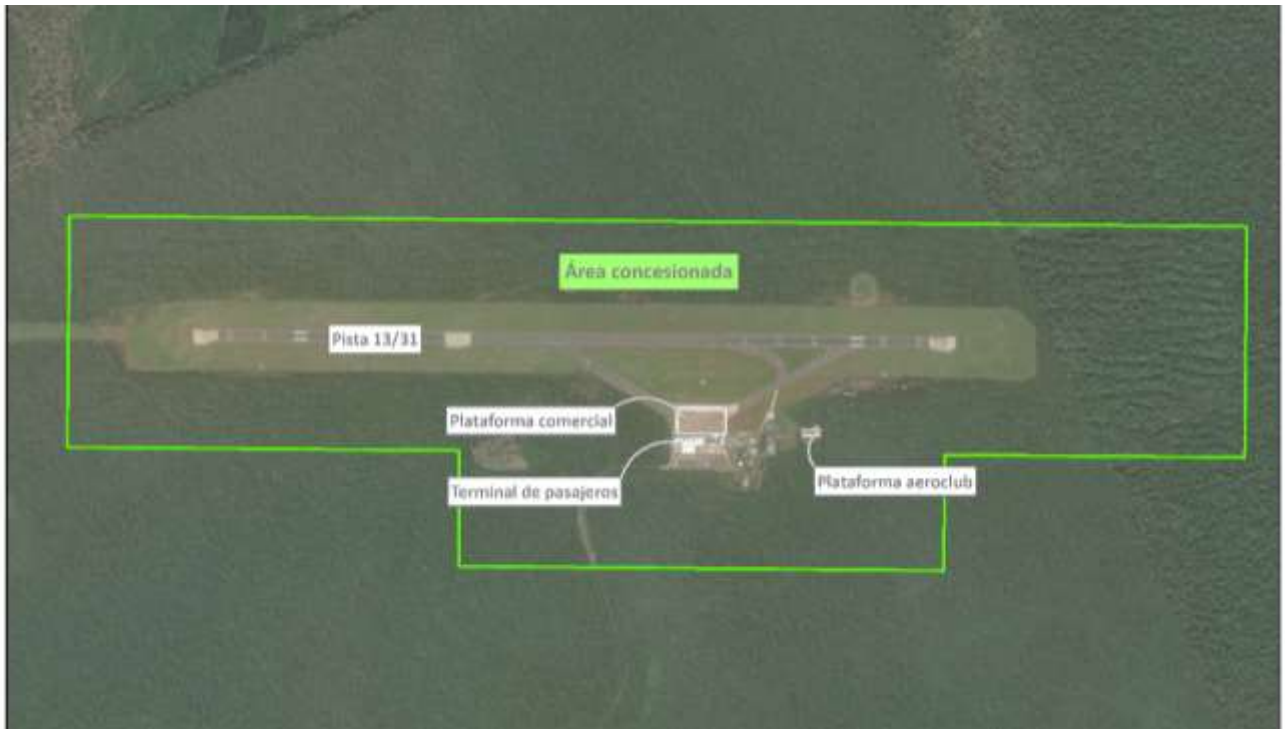
Imagen 1. Predio y área concesionada del Aeropuerto Internacional de Cataratas del Iguazú
