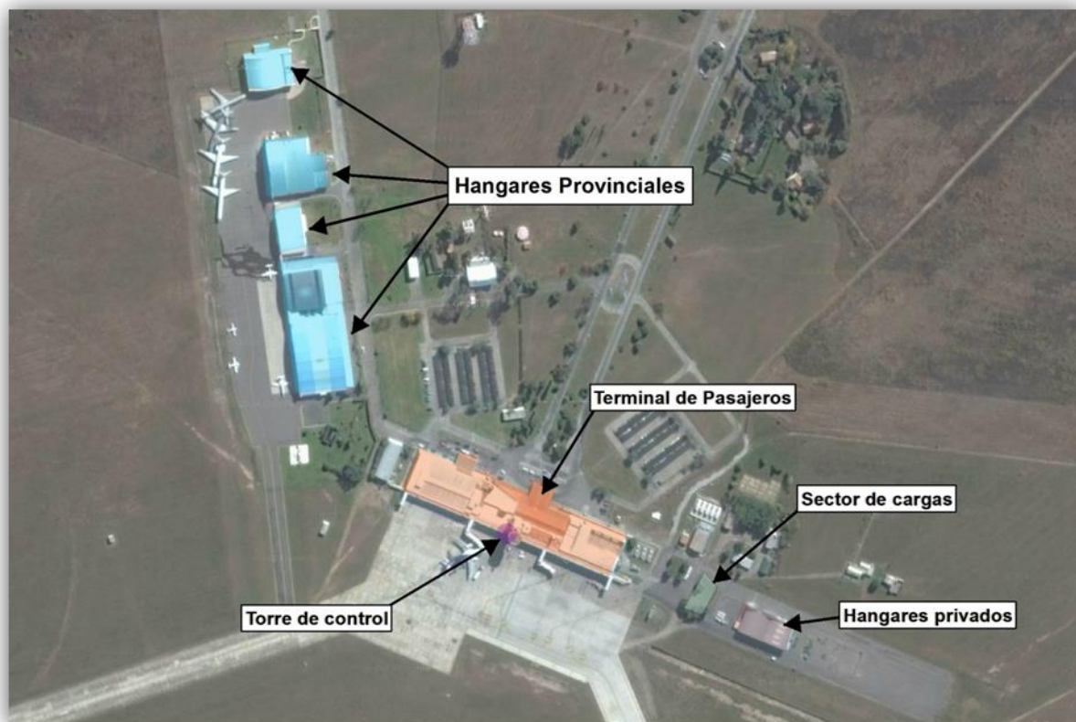
Imagen N°4: Sectores de lado público aeropuerto
