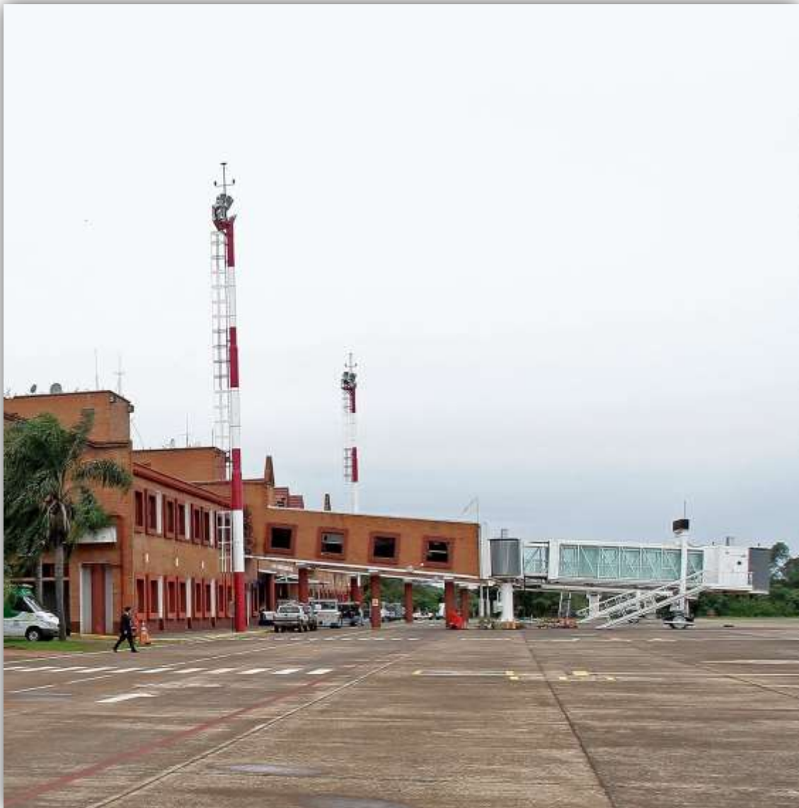
Imagen N°9: Plataforma del Aeropuerto Cataratas del Iguazú.
