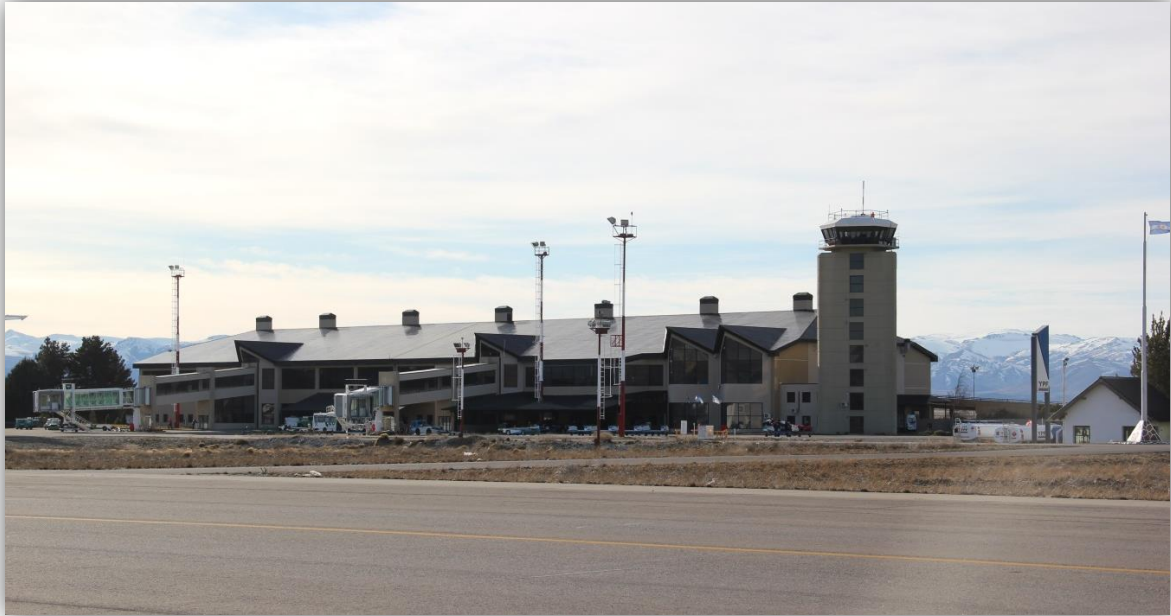
Imagen N°12: Plataforma comercial, aeroestación y torre de control del Aeropuerto Internacional de Bariloche.
