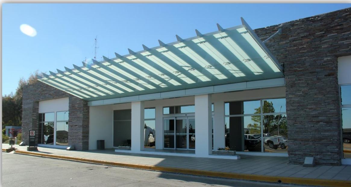
Imagen N°16: Terminal de pasajeros del Aeropuerto Internacional de Trelew.
