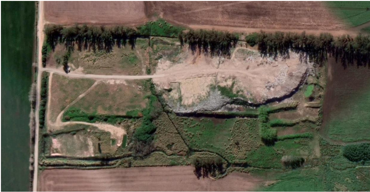
Vista Satelital Terreno de implantación del centro de tratamiento y disposición final.
