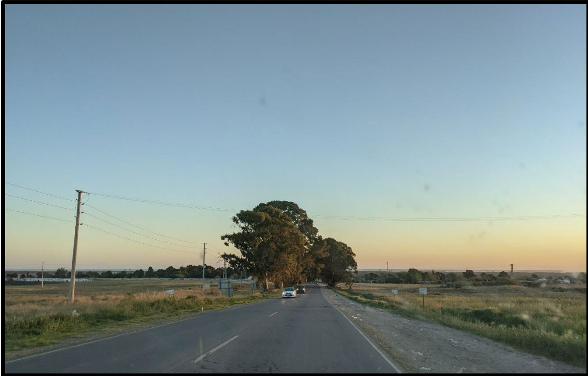
Figura 122 - Derivación desde RN3 a Villa Espora por calle Eduardo Sívori. Los carteles sobre derecha e izquierda indican cruce de oleoducto de Oldelval S.A. Foto: propia.
