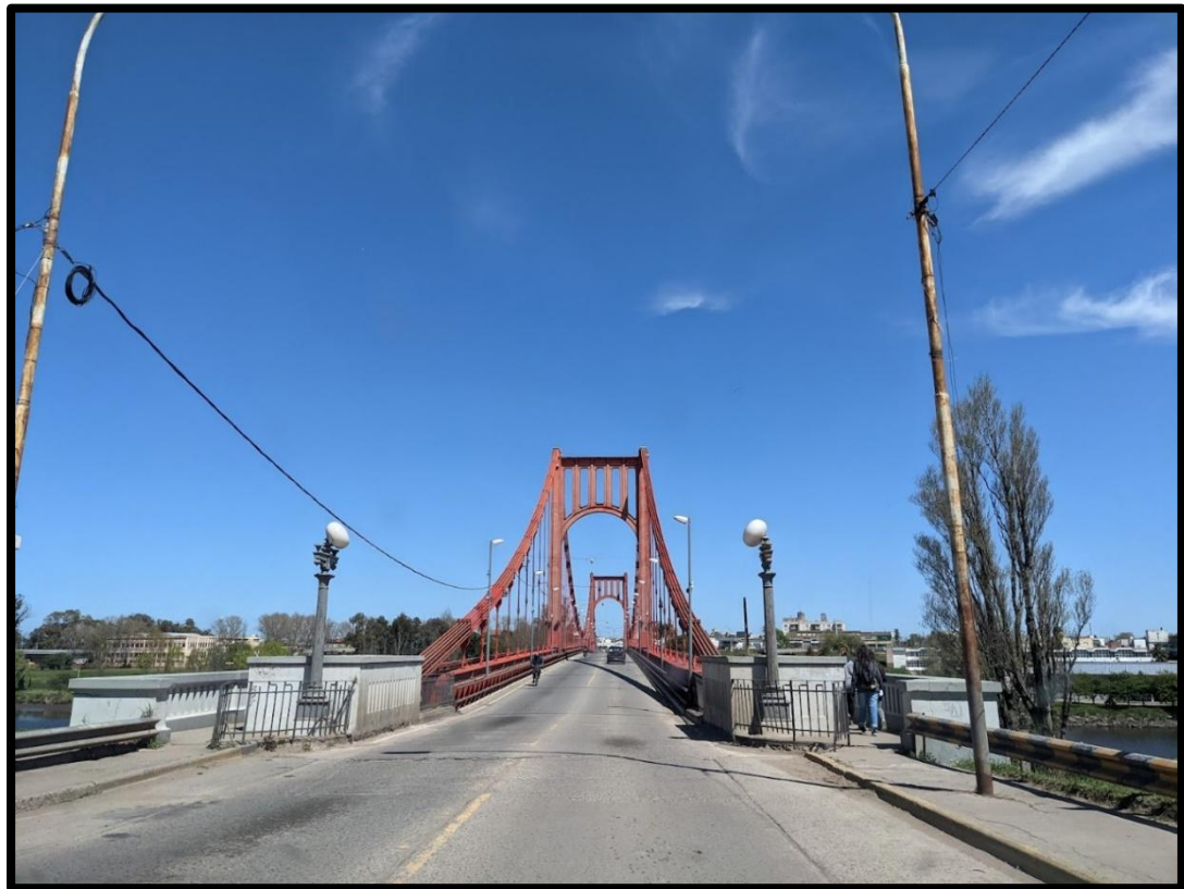
Figura 96 - Cruce del Río Quequén Grande, adosado al Puente Colgante Hipólito Yrigoyen. Foto: propia
