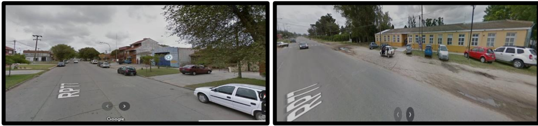
Figura 87 – Recorrido RP77, zona urbana de Miramar. Fuente Google Maps, 2021
