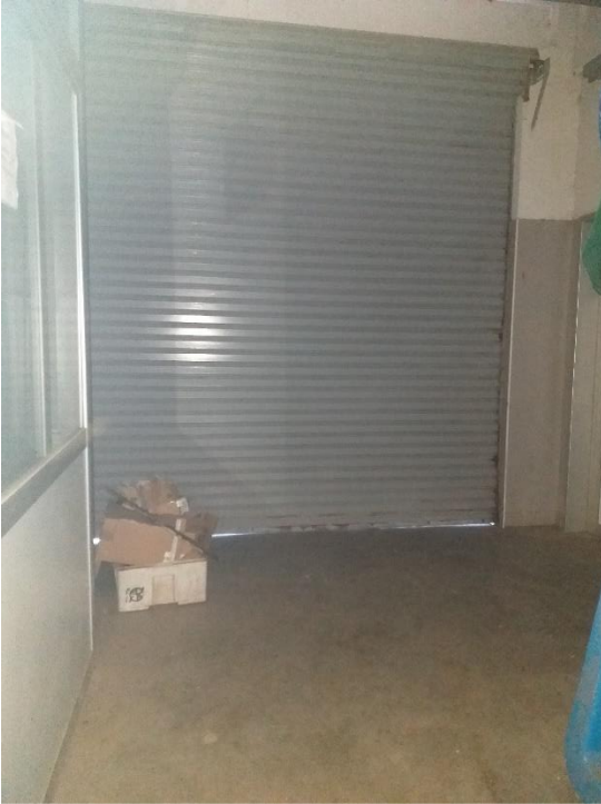
Vista desde el lado de adentro de la puerta que da al exterior.
